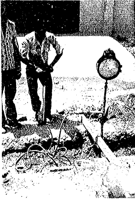
R.C.V.I 気密テスト ハンドポンプで空気を圧入中
