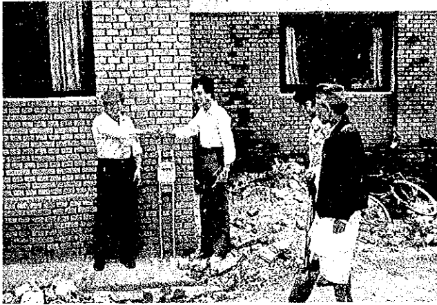
天然ガスメーター取付
