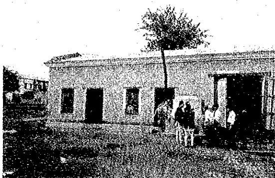
家内工業局敷地内手すき紙 Unit 用建屋
