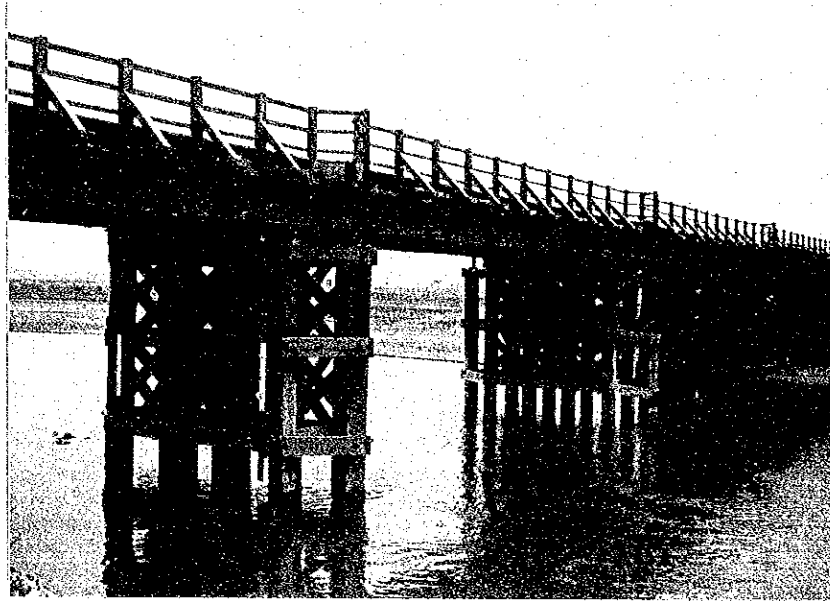
Biratnagar/Itahari間の道路橋 （Buri川に架かるもの。制限荷重： 乾期15t，雨期8t）
