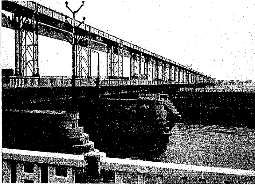
東西ハイウェイの橋梁の例 Kosi川取水堰に添加されているもの 全長1,200m（56スパン）
