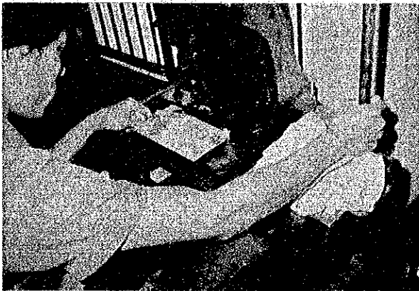
圧写後、不用部分を圧穿除去
