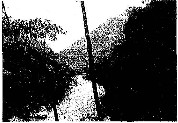
上流案ダムサイト（下流左岸より見る）
