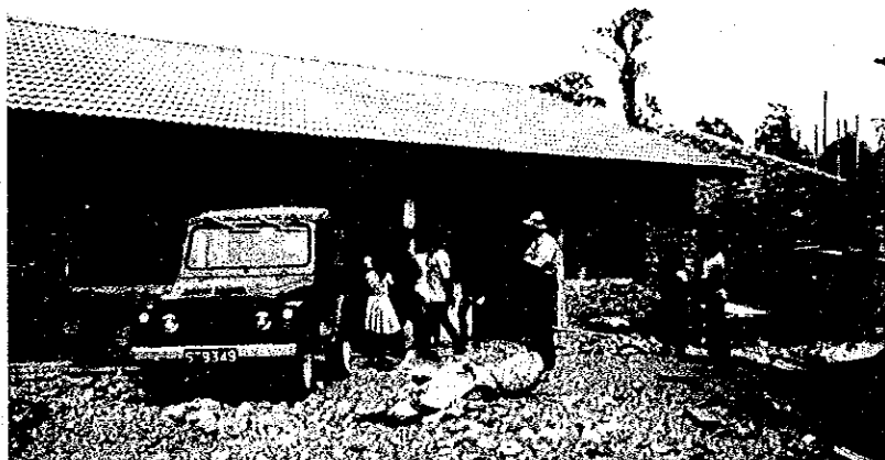
建設中の農園労働者用家屋（於タワウ）
