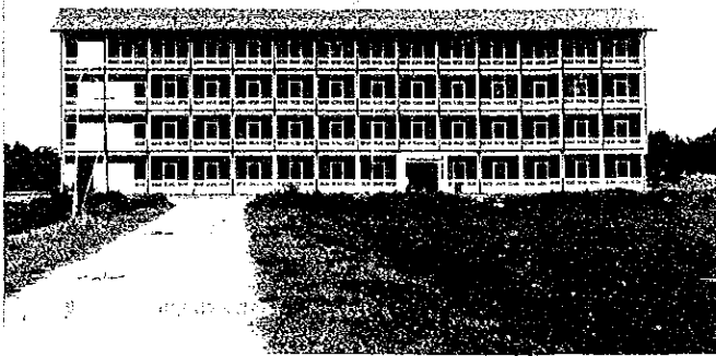
完成直前の研修本館（昭和58年7月撮影）
