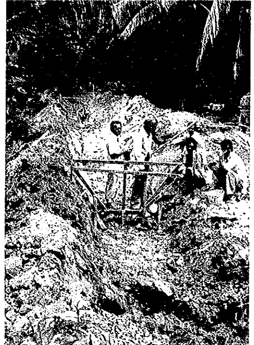
パイロットファームNo.3 導水路工事
