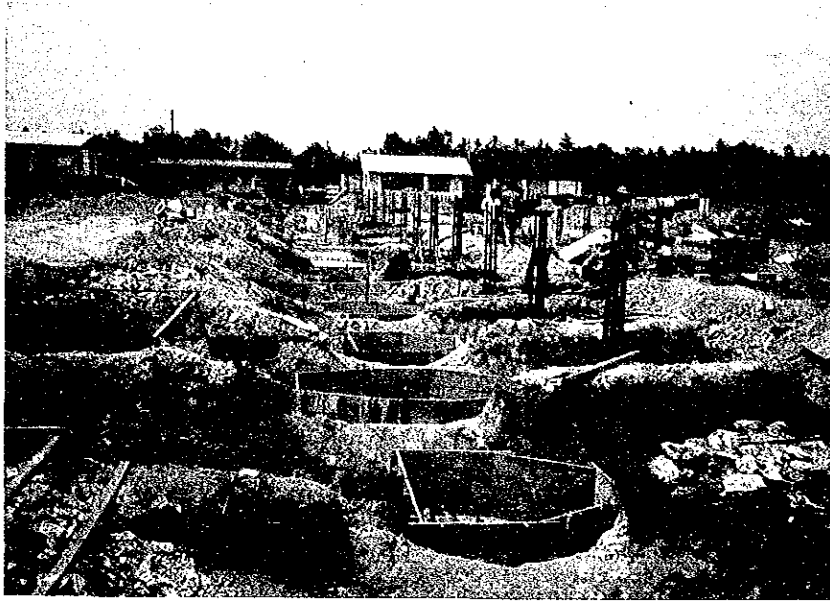
本館基礎杭頭処理
