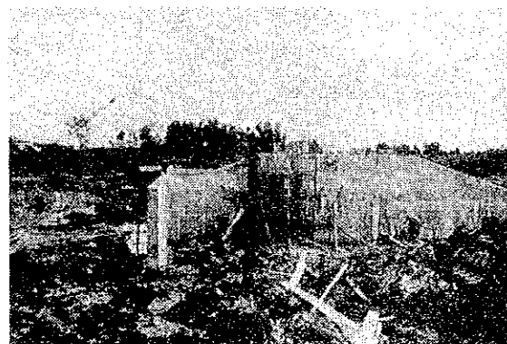
遊水池の掘削とスルースゲート工事
