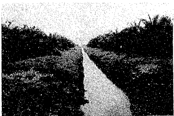
オイル・パーム園内を走る排水路
