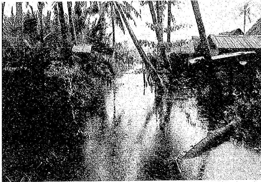
写真Ⅱ-6 バターワース地区での浸水状況
