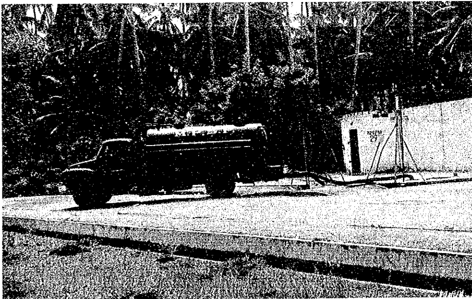
写真Ⅱ-4 浄化そうからの汚泥引き用ローリー
