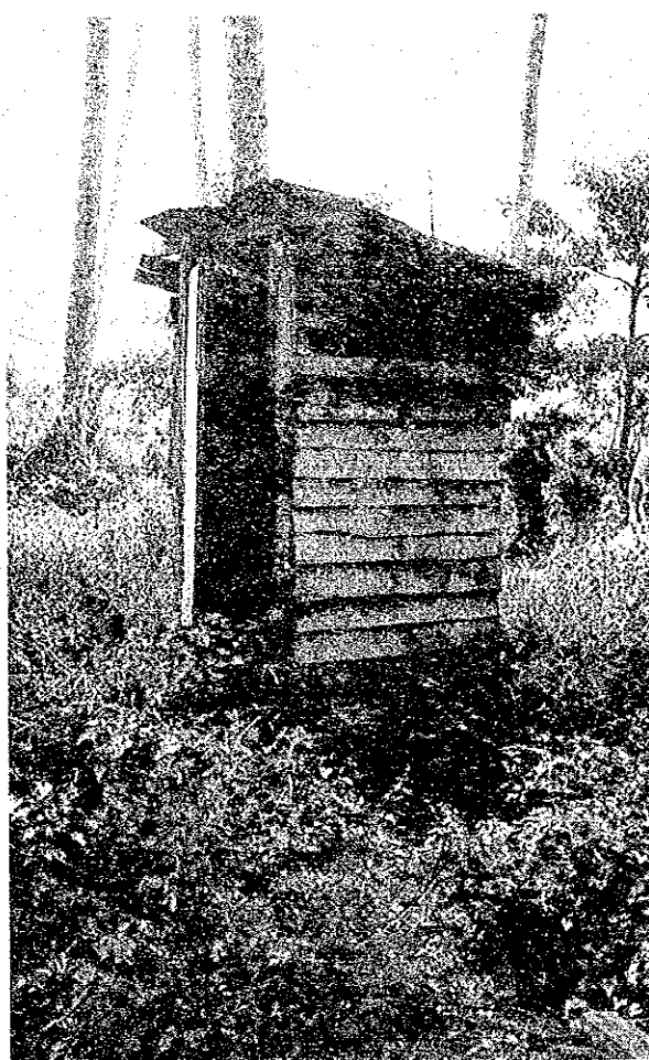
写真Ⅱ-2 浸透式便所
