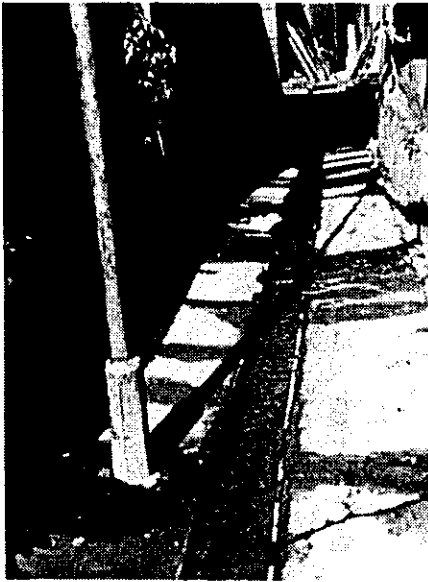
ブキットメルタジャム市内排水路
