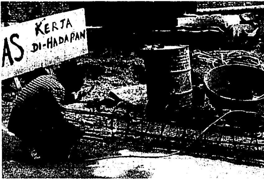
場所打ちコンクリート杭 の鉄筋かご組立
