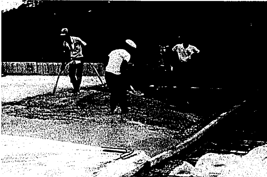
コンクリート打設
