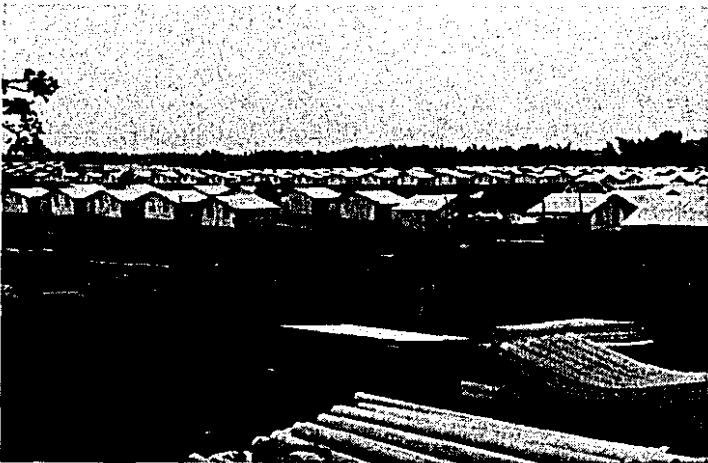
スラバヤ郊外 低価格住宅建設現場
