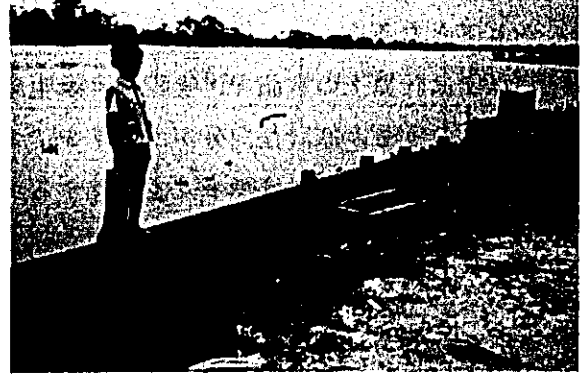
第 25 図 ゴトン・ロヨンでつくった河岸の柵 材料はウリン(Sebuluにて)
