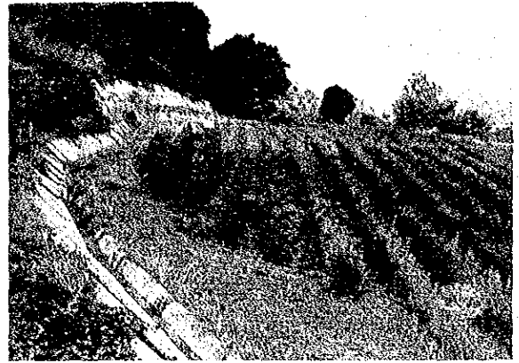
養蚕センター桑園のエロージョン防止工事 (モデルインフラ整備費)
