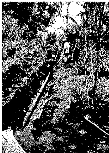
応急対策費にて行なわれている送水管補修工事
