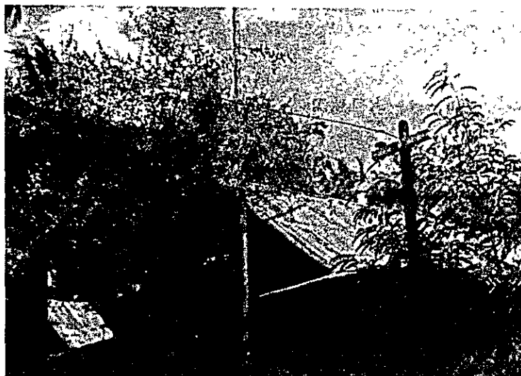
裸線一条方式市外線路
