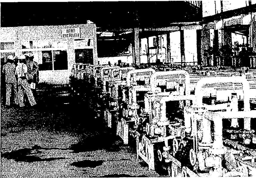
第2系列電解槽
