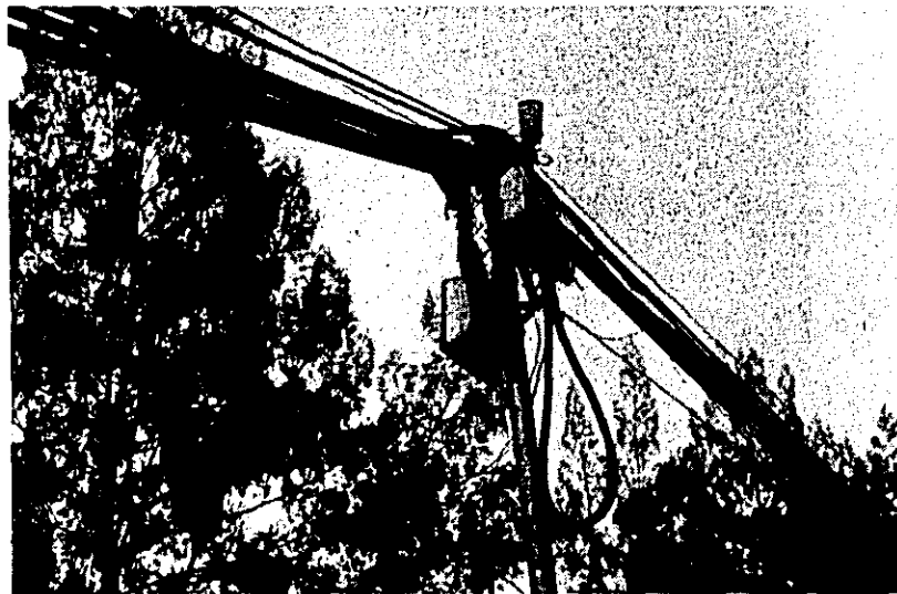
Fig. 1.7.7(2)½ ケーブル架渉状況
