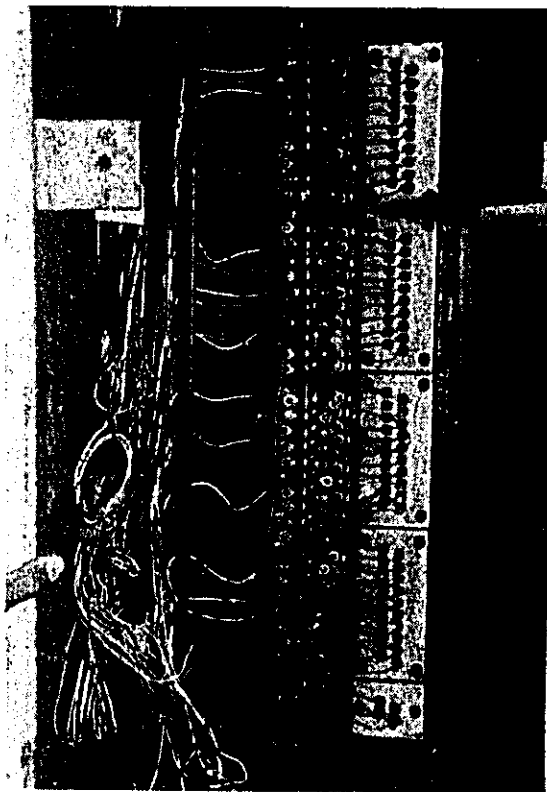
Fig 1.7.4(2) 4 / 8 鉄塔形端子函および木箱端子函の内部端子
