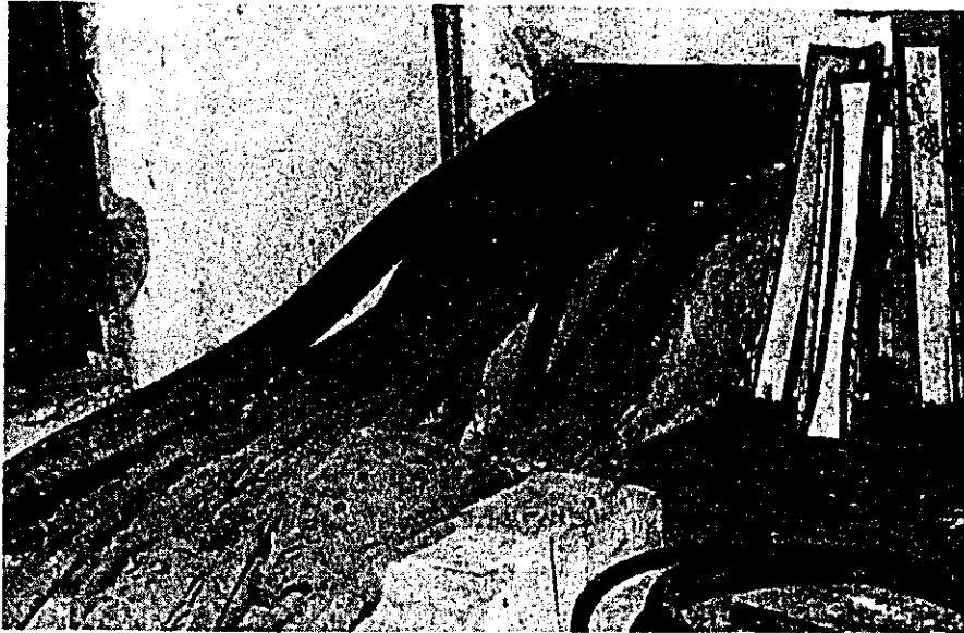
Fig. 1.7.2(3) 局 引 込 み
