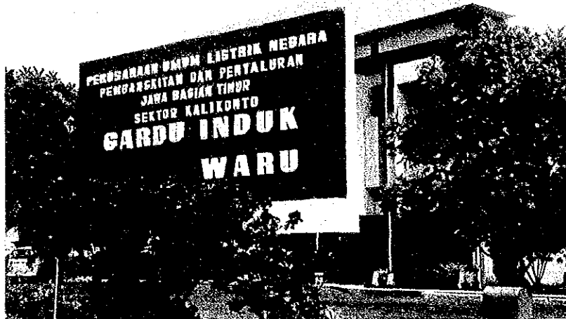
ワル ( Waru ) 変電所
