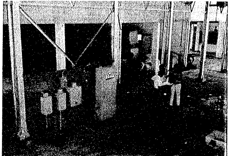
(3) プラント用配電盤
