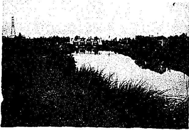
Pedjompongan 浄水場 取水口附近 Bandjir 運河
