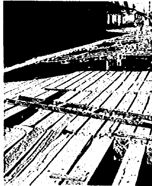
写真-8 Inner Harbour の老朽して使 用不能となった木造枝橋、順次 修復に着手されている。
