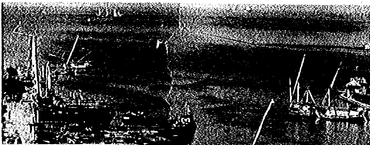
写真一 港口を固める西防波堤（左側）と東防波堤（右側）沖合に停泊している船は外航貨物船で、「はしり」により貨物の沖どり荷役が行なわれている。
