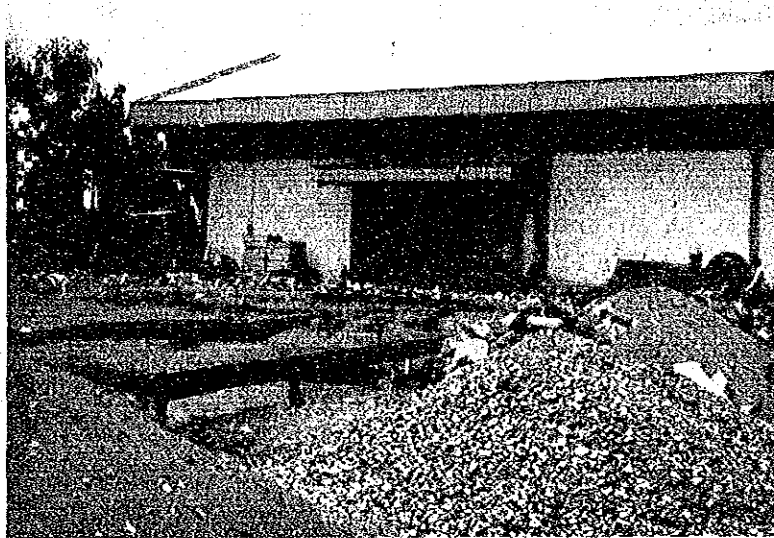
17. 水理実験棟 (手前は土質実験棟工事)
