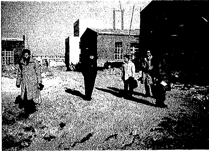
写真3. 実験棟工事現場
