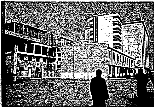
冷凍廠全景 (上海)
