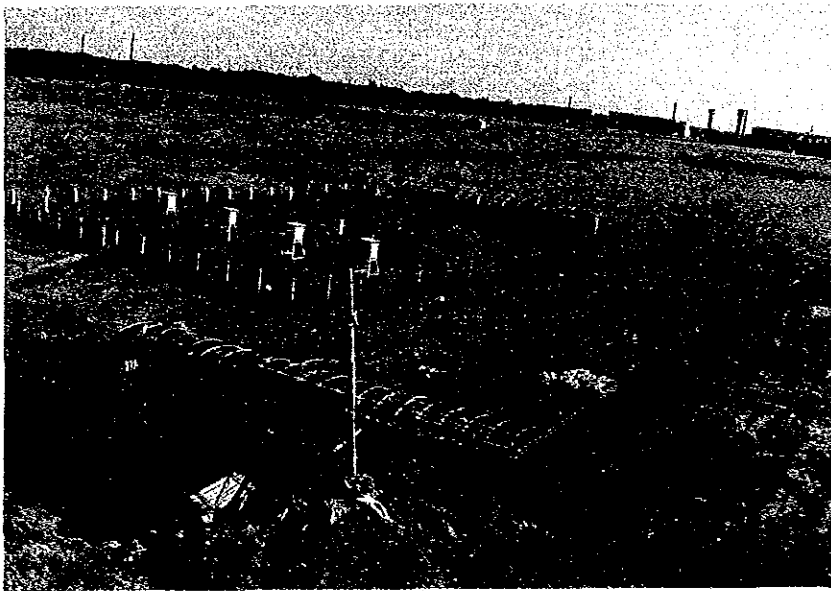
人工気象室建設予定地
