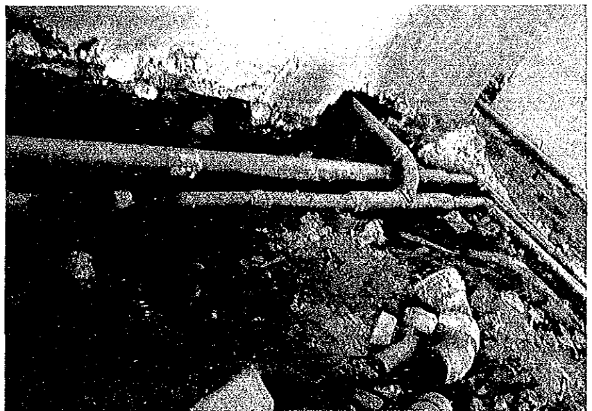
施工風景(配管工事)
