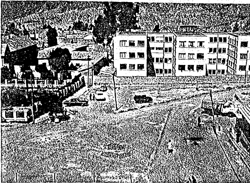
建設用地 (北側より見る)
