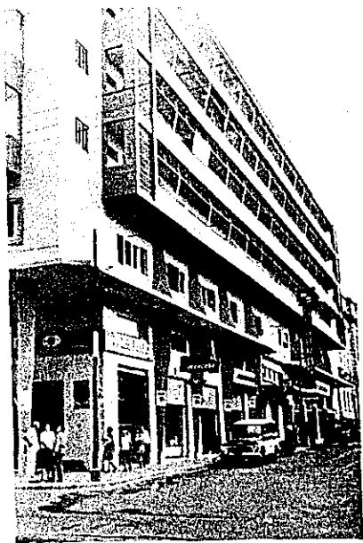
Asuncion の市内。近代建築も 建ち並んでいる。
