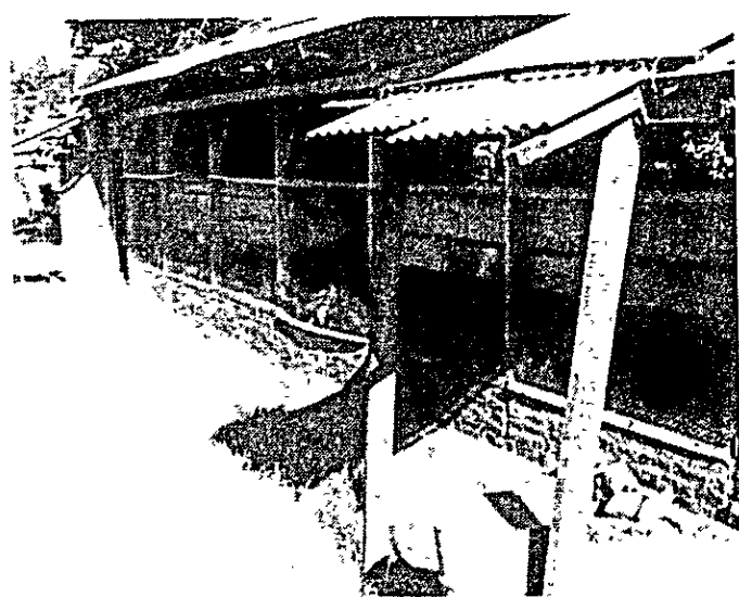
出入口はひさしが出ている
