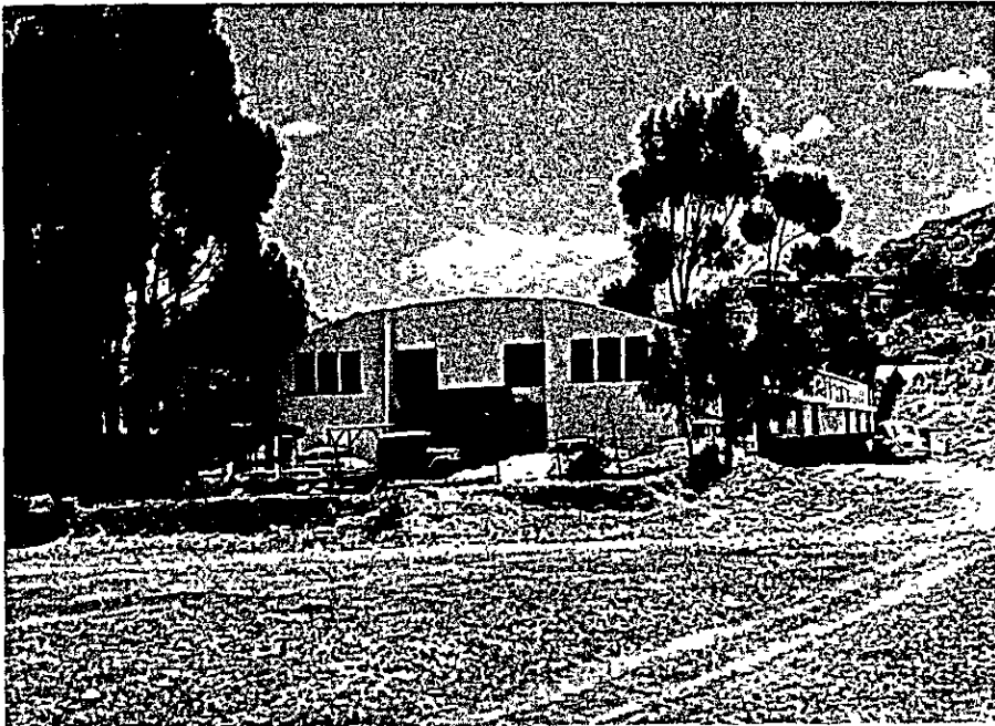
Foto-1 Edificio del Instituto de Geología Económica de la Universidad Mayor de San Andrés en el Campus de Cota Cota.. El Instituto de Geología Económica ocupa la mitad del edificio.
