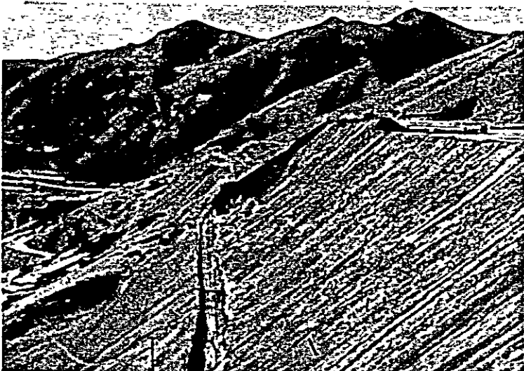
同上沈澱池の提体 (堆積量 約800万トン) (品位 亜鉛 4% 錫 0.4%)
