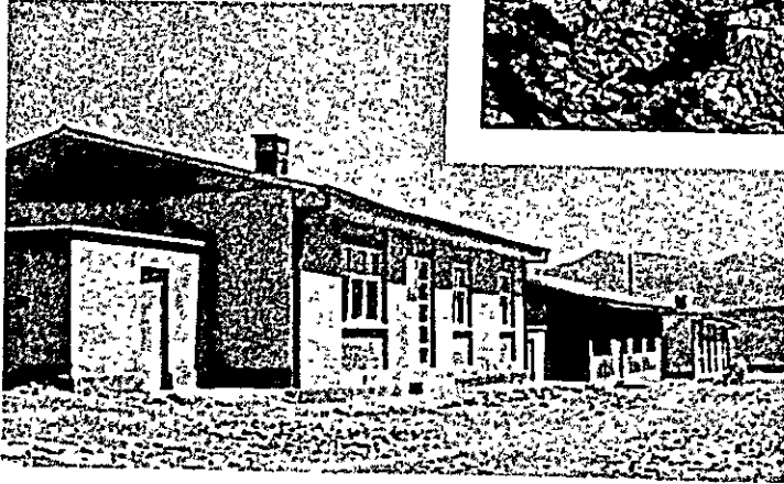
同 鉱山サイトに建 設中の職員社宅
