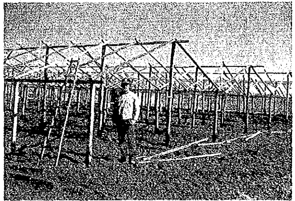
ビニール・ハウス建設状況 (ラ・プラタ小入植地)
