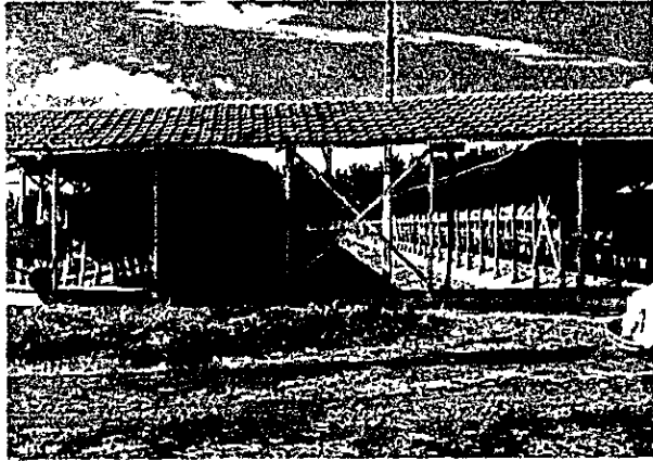
廊下で連絡しておるケージ鶏舎 両隣りでも作業がし易い
