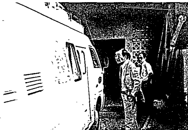
1985年5月にプロジェクトに到着し、活用されている中継車（わが方供与機材）
