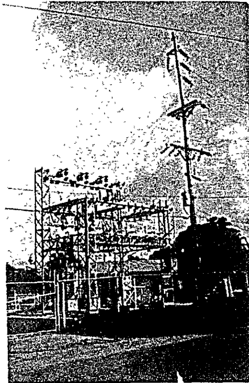
写真IV-1-5 ペノノメ変電所全景(34.5KV)
