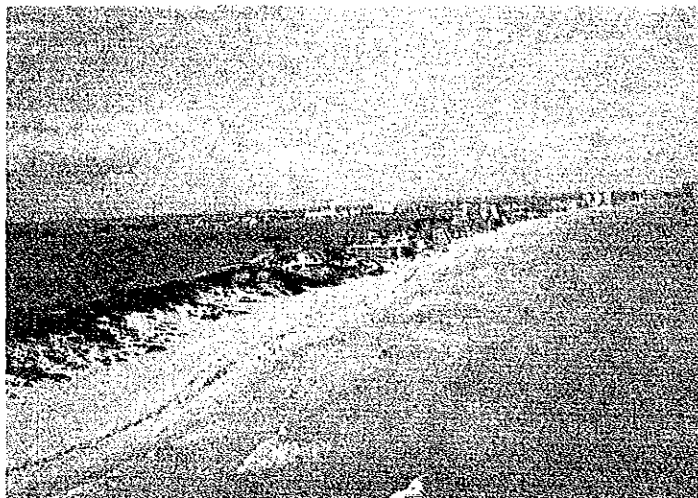
28. 世界的に有名な、カリブ海に面した保養地、カンクンの砂州に連なるホテル群。この地域での一般住宅などの建設は禁止されている（1983年12月石井専門家撮影）。
