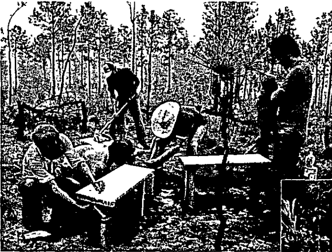
対空標識設置作業
