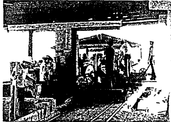
COMAYAGUAにおける旧式製材工場
