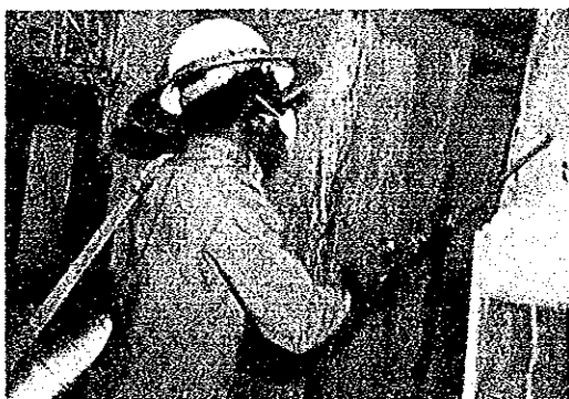
写真11 散布作業員の着装ヘルメットが頭に密着していないことに注意
