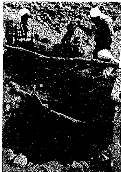
At TurよりHajjahへ 行く途中でみたワジ中で 掘さく中の浅井戸
