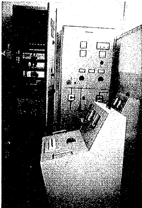
( 電源供給用配電盤 )
