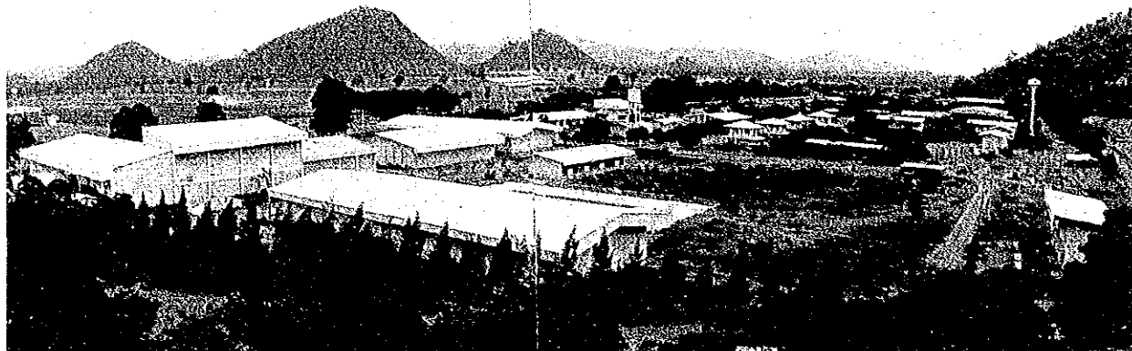
プロジェクトセンター全景（1984年6月）
