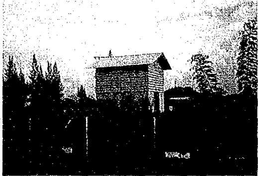
チャオピア・パイロット・プロジェクト主ポンプ場
