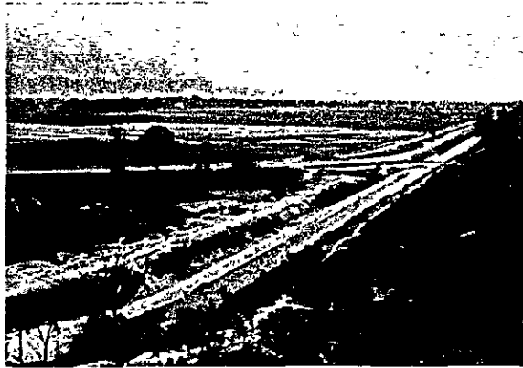
右岸幹線水路とKEW LOM IRRIGATION CANAL との接合地点
