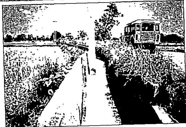
計画地区内の用水路 (水路内の電注の基部から水量の少なさがわかる)
