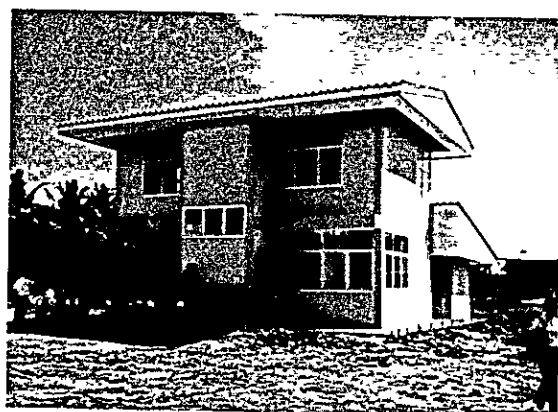
完成間近の専門家宿舎
