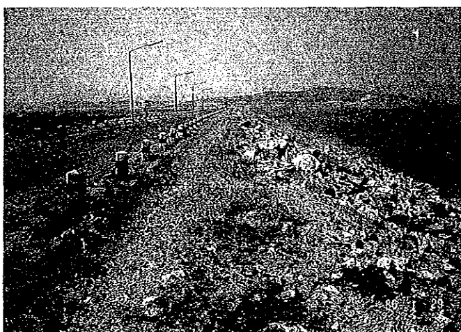
クラシオダムの堤頂部よりダム右岸を望む (現地調査)
